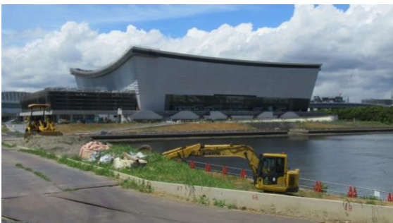
建設中の有明アリーナ (R1.8.13 撮影)
