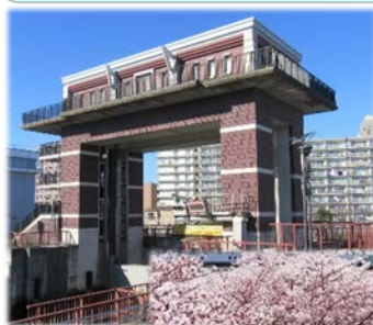
荒川 ロックゲート
